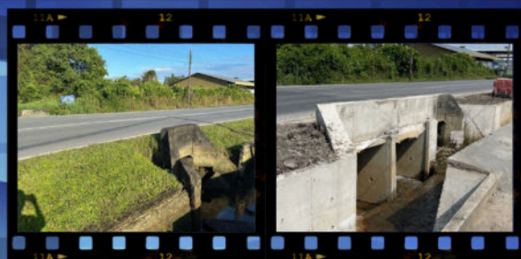
Naiktaraf Sistem Pembentukan Jalan Pinang Laka
